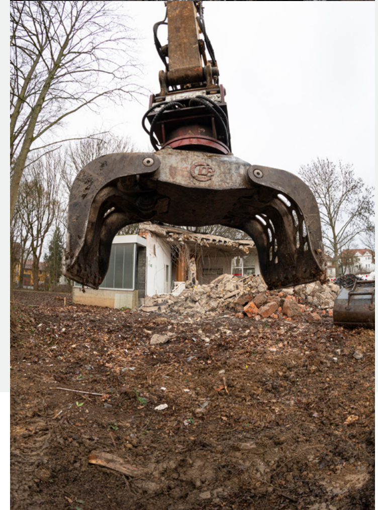
Das ehemalige Gebäude ist Geschichte
