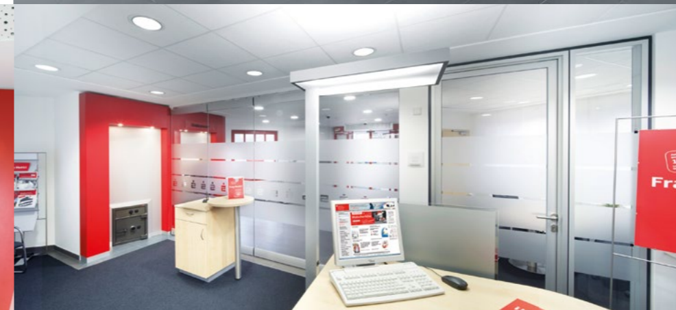
Beratungszimmer werden durch Glastrennwandanlagen geschlossen.
