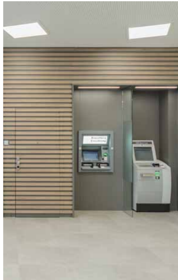
▲ SB-Bereich: Wand und Tür sind aus reinem Holzständerwerk
